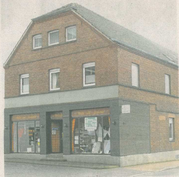
Das alte Haus Hövelmann wird sich in Nutzung und Gestalt völlig verändern. RN-Foto Schrief
